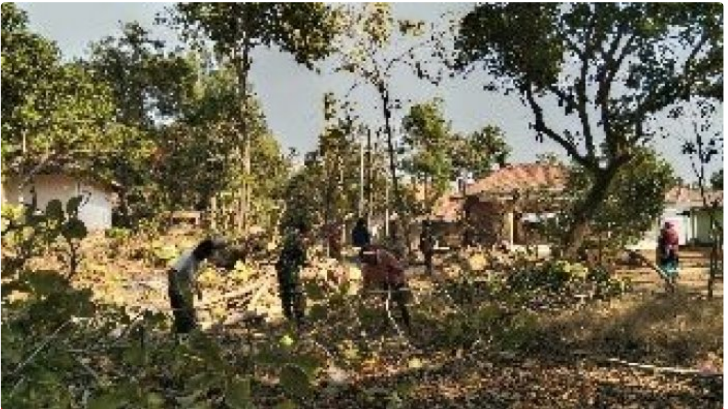
Babinsa Desa Jaddih Koramil 0829-02/Socah, Sertu Suwanto saat membersihkan Pohon dan ranting yang melilit di Kabel Listrik
